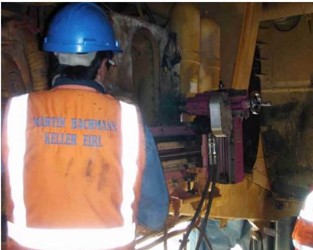
Nuestro personal supervisando el trabajo Fuente: P7270559.JPG
