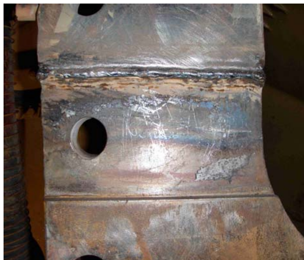
Canal de chavetero con aporte de soldadura
