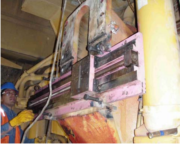
Cama con eje "X" instalada Fuente: P7270543.JPG
