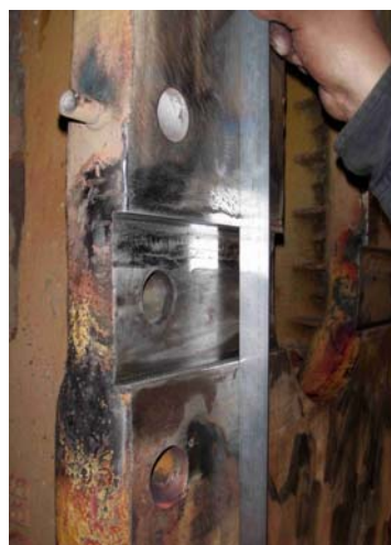
Planitud y acabado Fuente: P7270586.JPG
